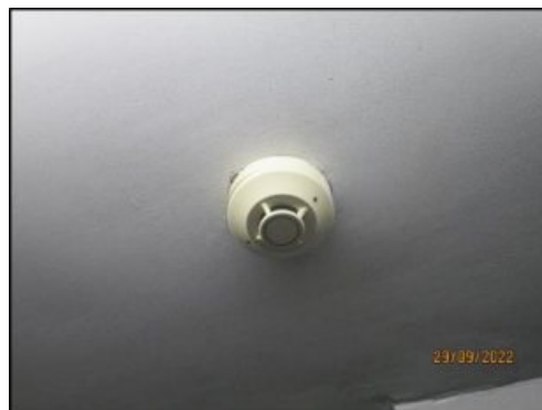
รูปที่ 2-42 เครื่องตรวจจับความร้อน (Heat Detector)
