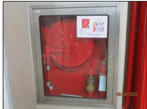
รูปที่ 2-33 ตู้เก็บสายฉีดน้ำดับเพลิงพร้อมอุปกรณ์
