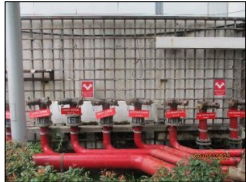
รูปที่ 2-32 หัวรับน้ำดับเพลิงภายนอกอาคาร
