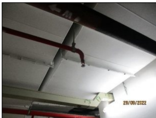
รูปที่ 2-36 ระบบหัวกระจายน้ำดับเพลิง อัตโนมัติ (Automatic Sprinkler System)
