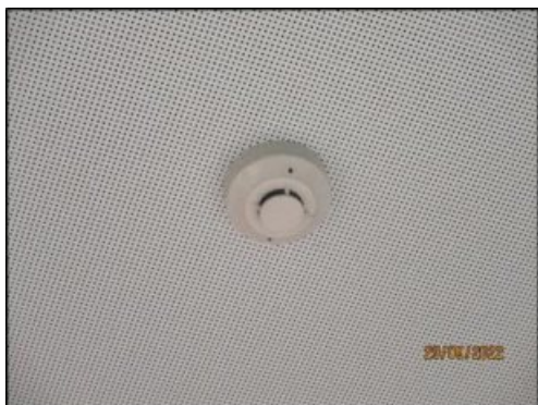
รูปที่ 2-41 เครื่องตรวจจับควัน (Smoke Detector)
