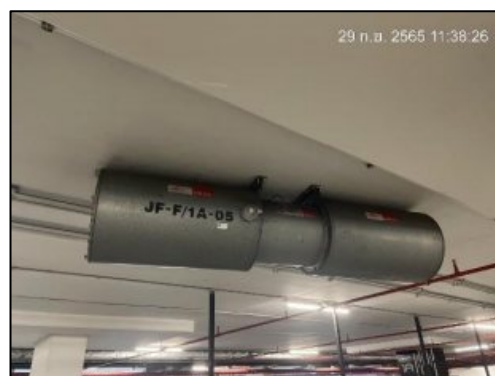
รูปที่ 2-6 การติดตั้งพัดลมดูดอากาศภายในอาคารจอดรถของโครงการ
