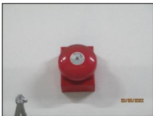
รูปที่ 2-43 สัญญาณเตือนภัยด้วยเสียง (Fire Alarm Speaker)
