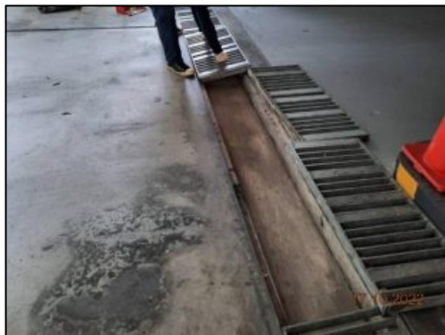
รูปที่ 2-18 การทำความสะอาดและลอกท่อระบายน้ำเป็นประจำทุกเดือน
