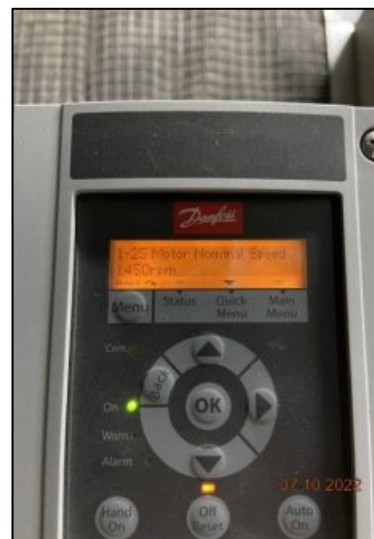
รูปที่ 2-30 อุปกรณ์ปรับความเร็วมอเตอร์ VSD ของเครื่องสูบน้ำ
