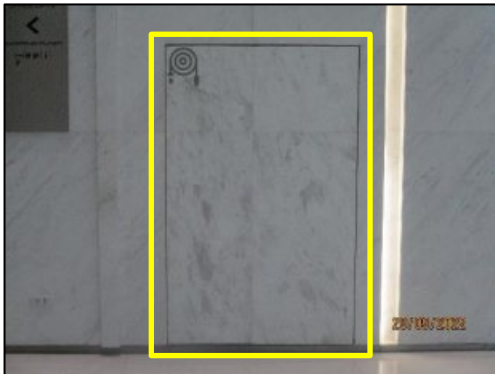
รูปที่ 2-33 ตู้เก็บสายฉีดน้ำดับเพลิงพร้อมอุปกรณ์
