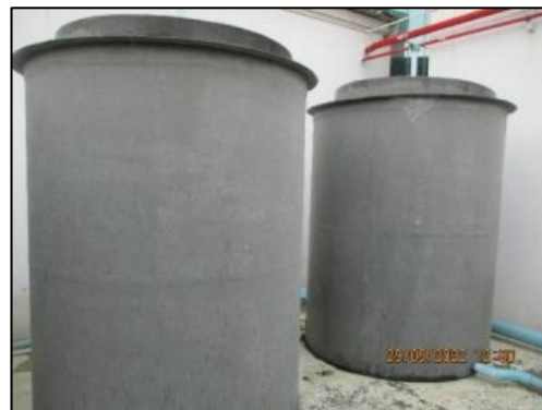
รูปที่ 2-11 ถังเก็บก๊าซมีเทน จำนวน 2 ถัง
