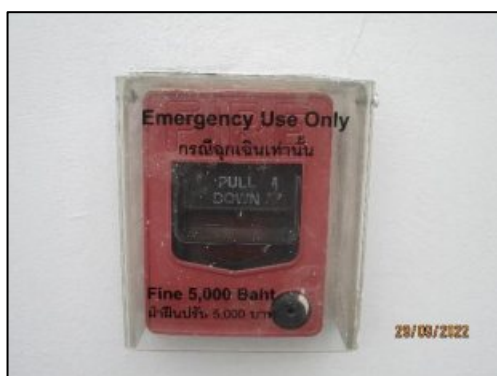
รูปที่ 2-44 เครื่องแจ้งเหตุโดยใช่มือดึง (Fire Alarm Manual Station)
