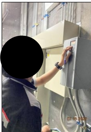
รูปที่ 2-30 อุปกรณ์ปรับความเร็วมอเตอร์ VSD ของเครื่องสูบน้ำ
