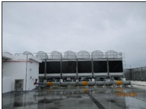
รูปที่ 2-52 หอระบายความร้อน
