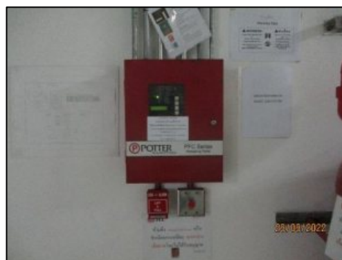
รูปที่ 2-40 แผงควบคุมระบบเตือนอัคคีภัย
