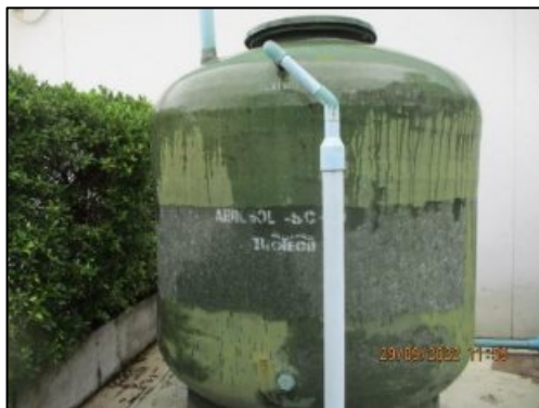
รูปที่ 2-10 ถังบำบัด Aerosol
